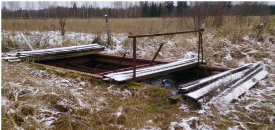
Foto 46. Kadjaste küla reoveepuhasti aeratsioonimahuti
