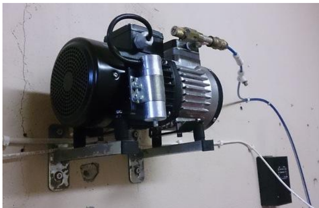
Foto 47. Kadjaste reoveepuhasti kompressor
