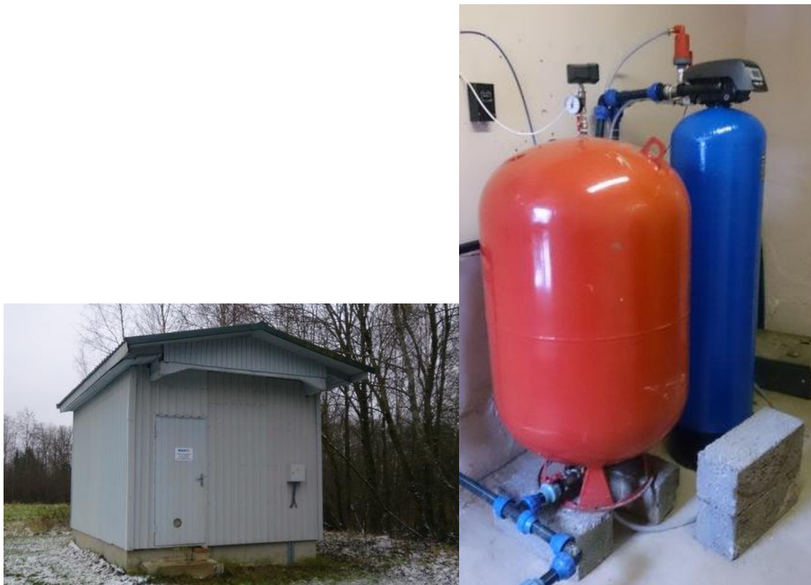
Fotod 43 ja 44. Kadjaste puurkaev-pumpla (katastri nr 6657) sise- ja välisvaade
