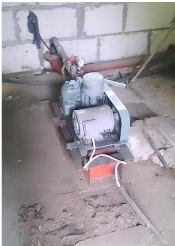
Foto 31. Aeratsioonimootor tehnohoones
